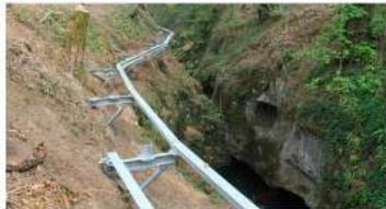
Jeux d'équilibre pour les encorbellements et les belvédères qui dominent les gorges. Les passerelles suspendues sont rehaussées par rapport aux initiales pour qu'elles soient hors de portée des crues centennales.
