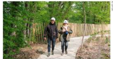
Une promenade, également accessible aux personnes à mobilité réduite. Ici, Isabelle Chappuis-Martinez, architecte en charge du projet et Sébastien Pomini, président de l'Association Au cœur des gorges du Sierroz. Le sable provient de la carrière de Grèsy-sur-Aix, toute proche.
