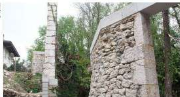
Impressionnants, les travaux mettent en valeur ce patrimoine, classé site emblématique par la Région Auvergne Rhône-Alpes.
