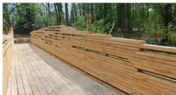
Fas de site historique, sans légende : la passerelle du contrebandier enjambe le Sierroz pour passer sur l'autre rive. Avec l'utilisation du bois, elle rappelle l'ancienne scierie. Cette passerelle est constituée de 136 m 2 de platelage chêne et de 40 m 2 de basting d'habillage chêne.
